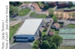
Les travaux du complexe sportif n° 1
